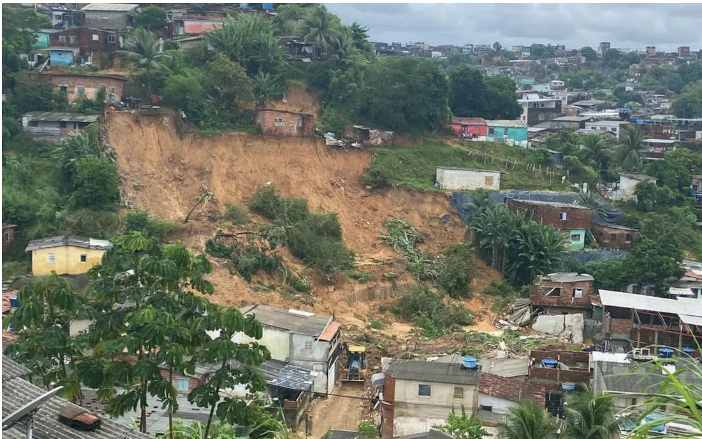
Fig. 1. Desabamento de terra no bairro de Jardim Monte Verde, Recife, em maio de 2022. Fonte: Pedro Alves/G1 Pernambuco.
