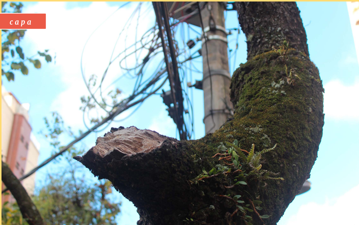
Eletricidade e Arborização Urbana Foto: Célio Bermann, 2020 São Paulo-SP
