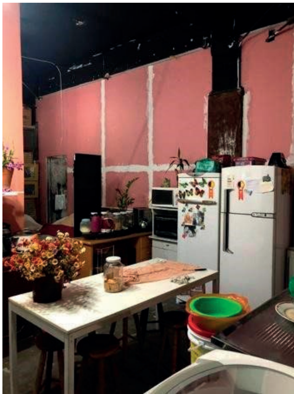
Figura 3 - Dry-wall instalado. Fonte: Projeto de Extensão ‘Quem ocupa não tem culpa’.
