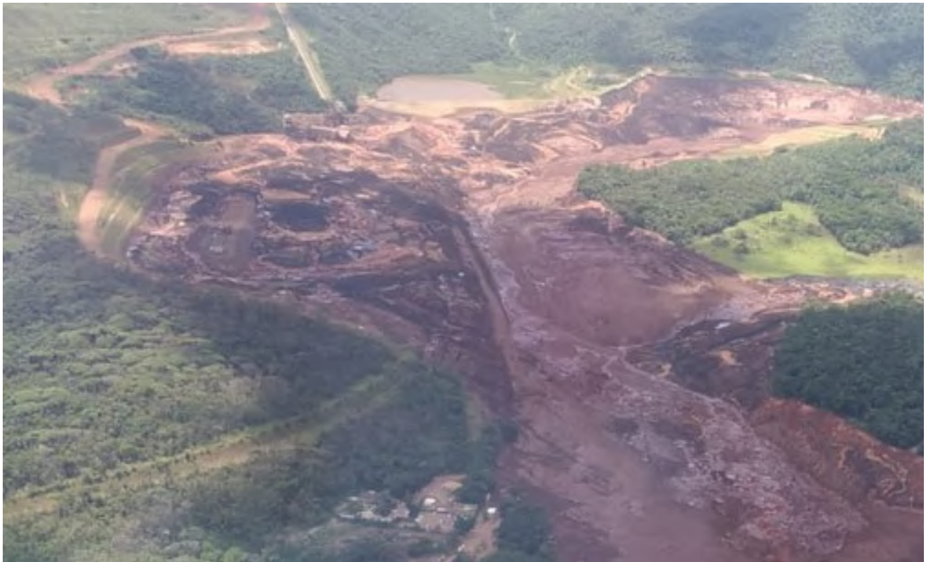
Figura 1: Imagem do local do rompimento da barragem na comunidade do Córrego do Feijão Fonte: Corpo de Bombeiros de Brumadinho
